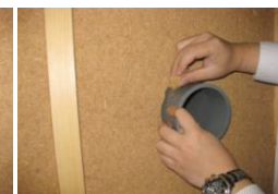
隙間に端材を詰める
