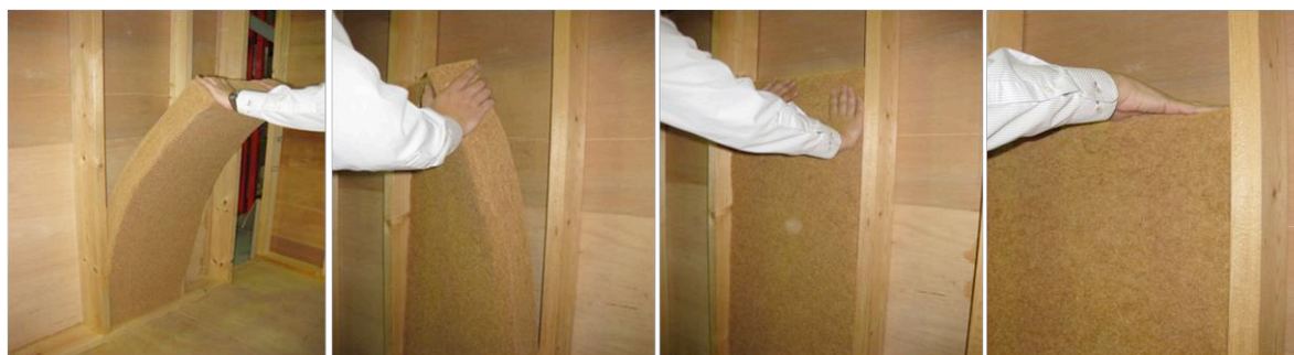
下部に隙間が生じないよう、上から押し付ける
