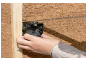
作業用カッターでコンセントの形に切り込みを入れる
